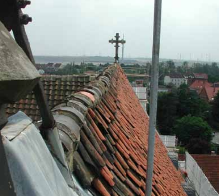
Das Dach vor der Erneuerung.
